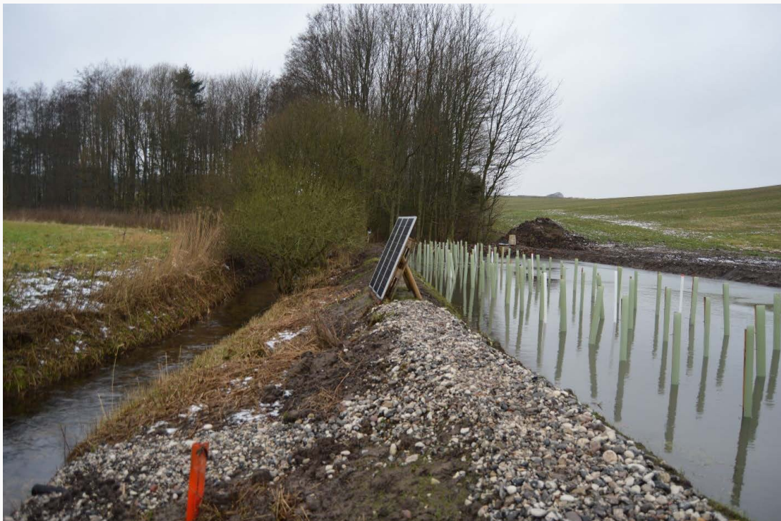
Drænvandet i IBZ skal stå ca. 0,7 meter højere i forhold til vandløbet. Dette sikrer god jordinfiltration og dermed også en mere sikker denitrifikation. Foto Frank Bondgaard
